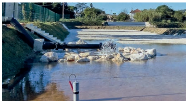
Bassins d'infiltration du dispositif de RMA mise en place sur le territoire de la Ville d'Hyères-les-Palmiers ©Suez
