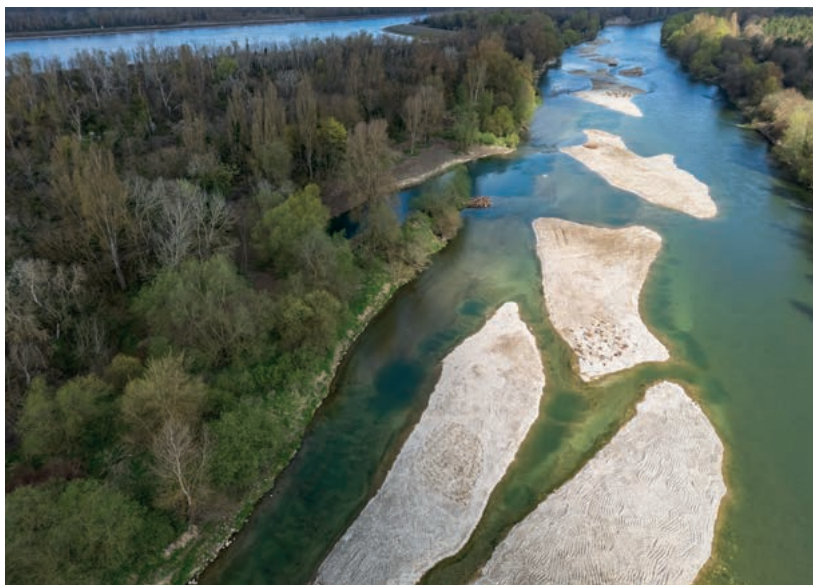
Travaux de réinjection sédimentaire et de renaturation dans le lit du Vieux Rhin, réalisés par EDF Hydro Est ©Gregory Tachet
